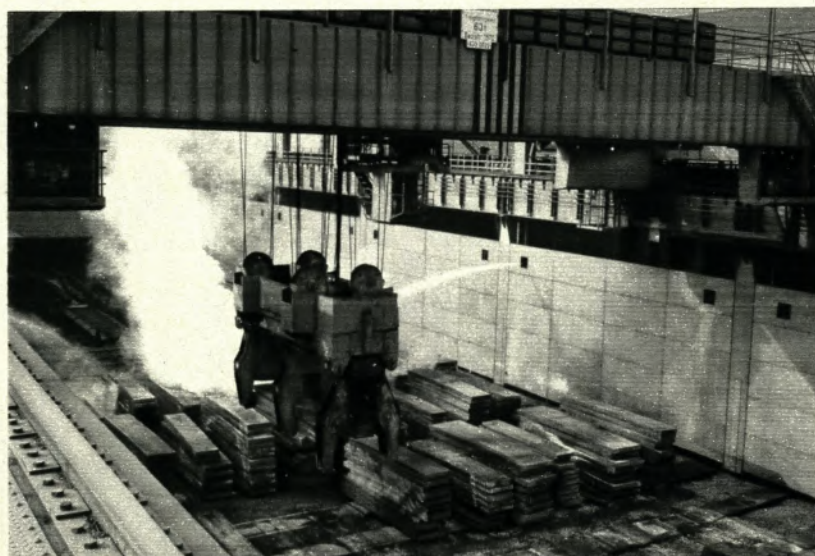
◀ Ein anderer der fünf neuen Brammentransportkrane; er arbeitet auf dem Kühlplatz zwischen Blockbrammenstraße und Flämmhalle
