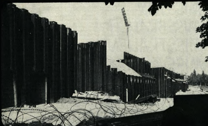
Man sieht die rückwärtige Stirnwand aus dem Hoesch Profil 134 in Sonderstahl. In der Bildmitte ist deutlich eine der breit angelegten Treppennischen erkennbar. Links sind Öffnungen für einen Fußgängertunnel und die Toilettenanlagen gelassen.
