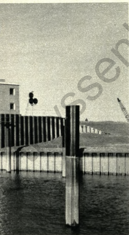
◀ Schutz durch Spundwand: 2000 Tonnen Hoesch-Stahlspundwand sichern die beiden Sperrwerke, die der Schifffahrt freie Durchfahrt gewähren — deren mächtige Tore aber unerwünschten Wasserfluten den Einfall verwehren
