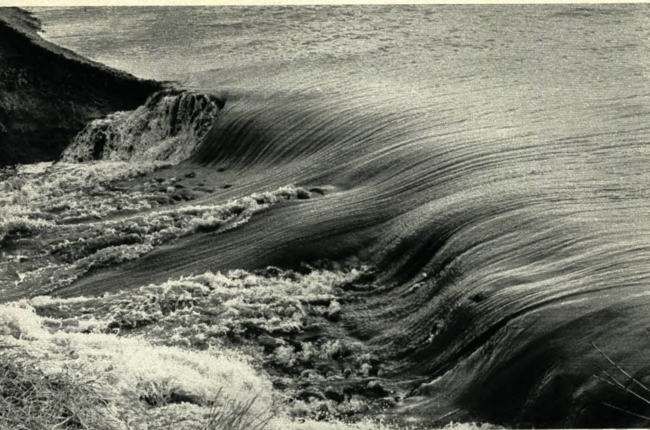
◀▼ Bei der Sturmflut 1962 wurde der Deich allein zwischen Bützflethersand und Stadersand achtmal durchbrochen. Heute ist der Deich vorverlegt und erhöht und um zwei Sperrwerke ergänzt, die das Eindringen des Wassers in die Schwinde und Bützflether Südelbe bei künftigen Sturmfluten verhüten
