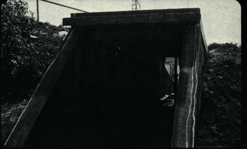
Das fertige Bauwerk des Fußgängertunnels zeichnet sich schon ab. Die beiden Spundwände sind durch die Deckplatte gegenseitig ausgesteift. Die Vertikallasten dieser Deckplatte werden über die Spundwände in den Boden geleitet.
