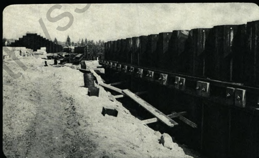
Die rückwärtige Längswand von der Erdseite gesehen. Hier wird die Vergütung aus zwei U-Eisen eingebaut. Die Gurte wurden mit eingeschweißten Abstandshaltern geliefert.
