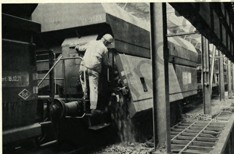
Aus Großraum-Selbstentladewagen wird das Erz in die darunterliegenden Erzbunker abgeladen.
