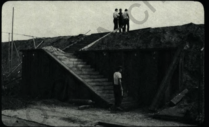
Nachdem die Bohlen an der Oberkante schräg abgeschnitten wurden, ist der Eisenholm aufgebracht worden. Der Treppenaufgang steht vor der Fertigstellung.
