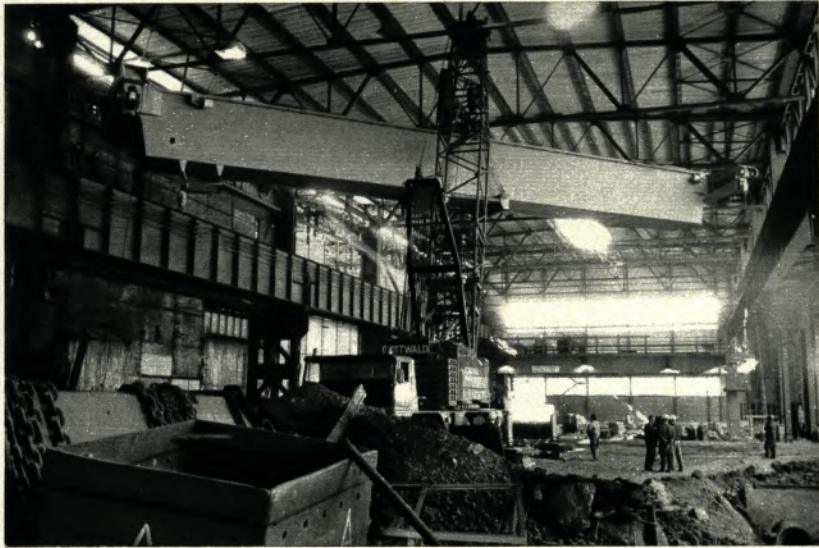
◀ Einer der torsionssteifen Kranträger in Kastenbauweise wird montiert
