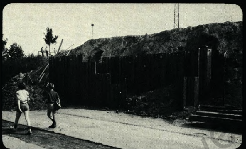
Die Stahlspundwände unmittelbar nach der Rammung eines Treppenaufganges. Hier im Stadion Flinger-Broich sind Larssen-Profile 20 eingerammt.
