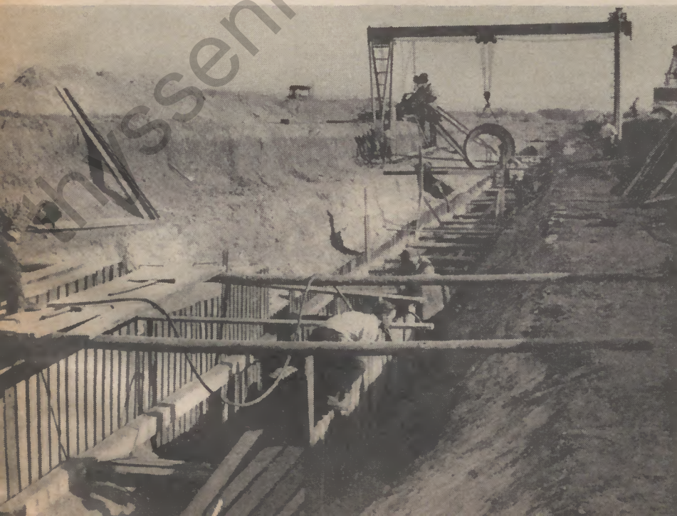
Einsatz von Hoesch-Kanaldielen „Kölner Modell“ bei der Verlegung von Schleuderbetonrohren in Tiefen bis 8,0 m, Bauherr: Stadtentwässerungsamt Frankfurt/M., Baufirma: Rheinbeton, Koblenz, Baujahr: 1960
