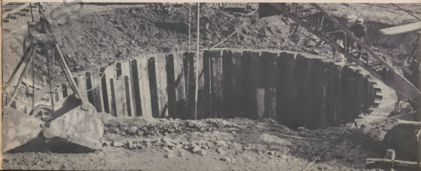
Hoesch-Stahlspundwand, Profil II, in St. 37, 8,0 und 12,0 m lang, für eine Kreisrammung beim Bau der Kläranlage Aschaffenburg, 11,4 m Durchmesser, Bauherr: Stadtverwaltung Aschaffenburg, Baufirma: A. Hörnig, Aschaffenburg, Baujahr: 1960
