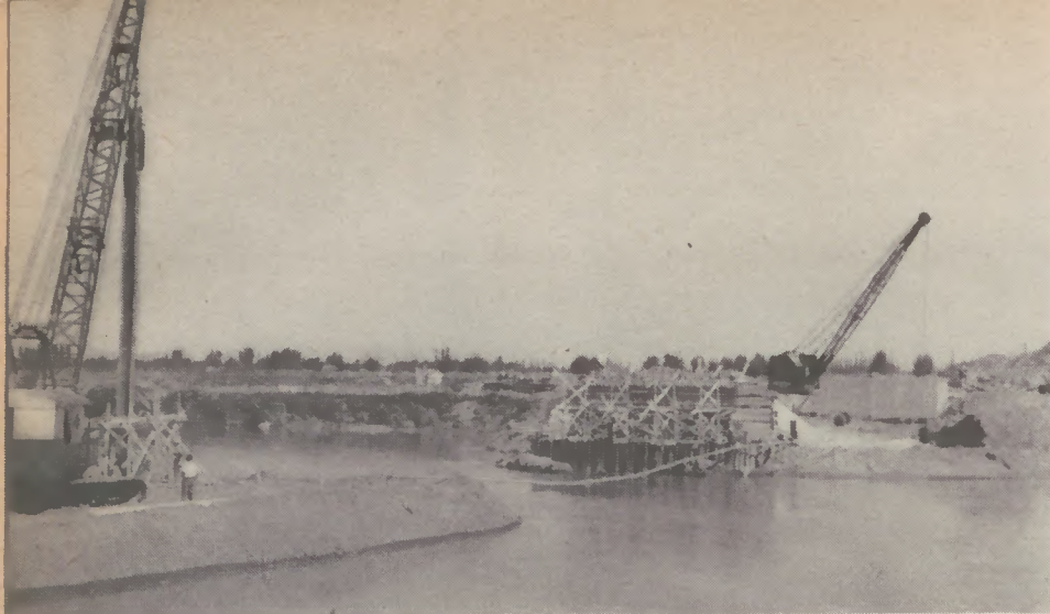
Hoesch-Stahlspundwand, Profil II, in St. 37, 8,0 m lang, für die Gründung eines Brückenwiderlagers an der Autobahn zwischen Athen und Saloniki
