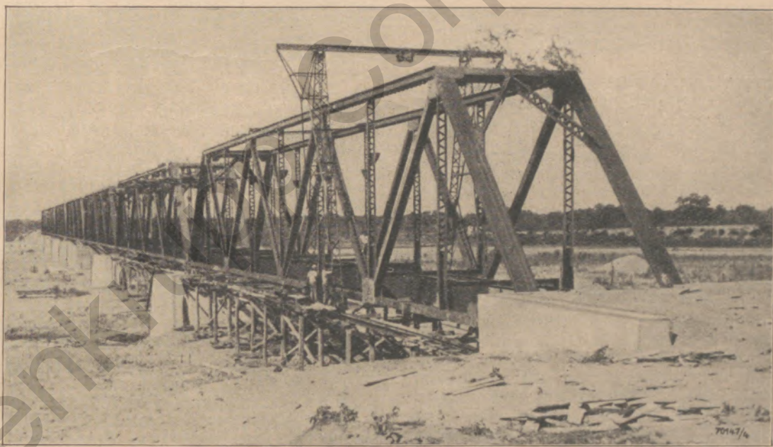
Brücke über den Rio Pajaje
