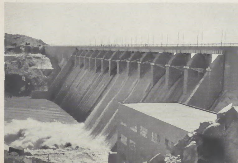
Energieversorgung vordringlich: Eine Wirtschaft ohne Energie ist nicht denkbar. Der Tilaya-Damm ist ein Beispiel für die Nutzbarmachung natürlicher Energiequellen zur Gewinnung von Kraftstrom
