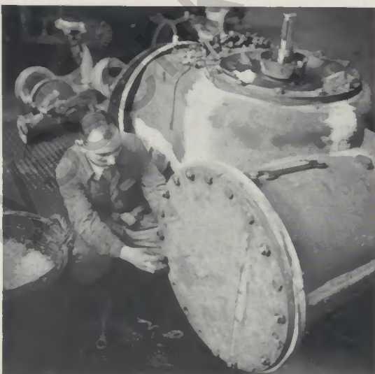
Vollautomatische Schöpfwerkspumpen im Prüffeld: Die drei neukonstruierten Propellerpumpen für das Schöpfwerk Waakhausen (Teufelsmoor) arbeiten in Folgeschaltung, wobei die Schaufelstellung elektropneumatisch in Abhängigkeit vom Wasserstand gesteuert wird. (Das Foto zeigt Elektromeister Limbach)
