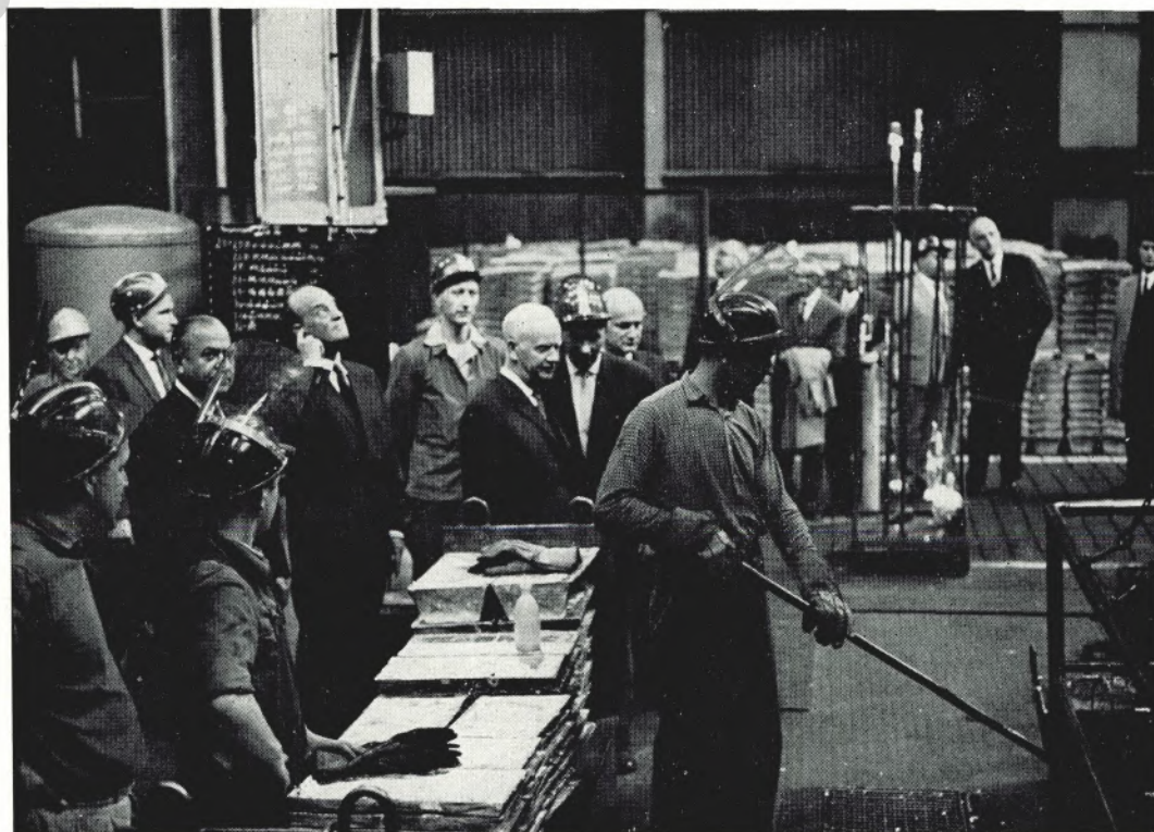
Betriebsleiter Stein erläutert Dr. Lübke die Arbeit der Verzinkungsanlage
