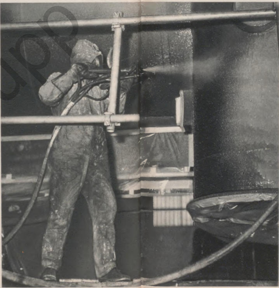
► Hoesch hat das Labor gegen Korrosion und vor allem gegen Wärmeverlust bei den niedrigen Wassertemperaturen durch eine Kunststoff-Isolierung geschützt
