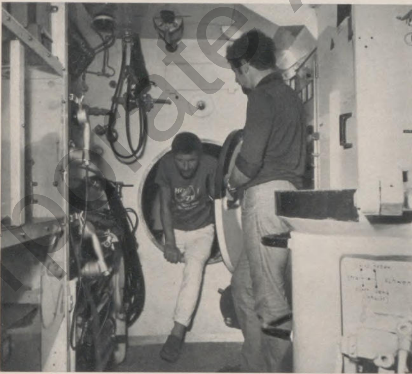
▲▲ Das Labor ist ein zylindrischer Körper, der neun Meter lang ist, auf vier Beinen steht und 75 Tonnen wiegt
