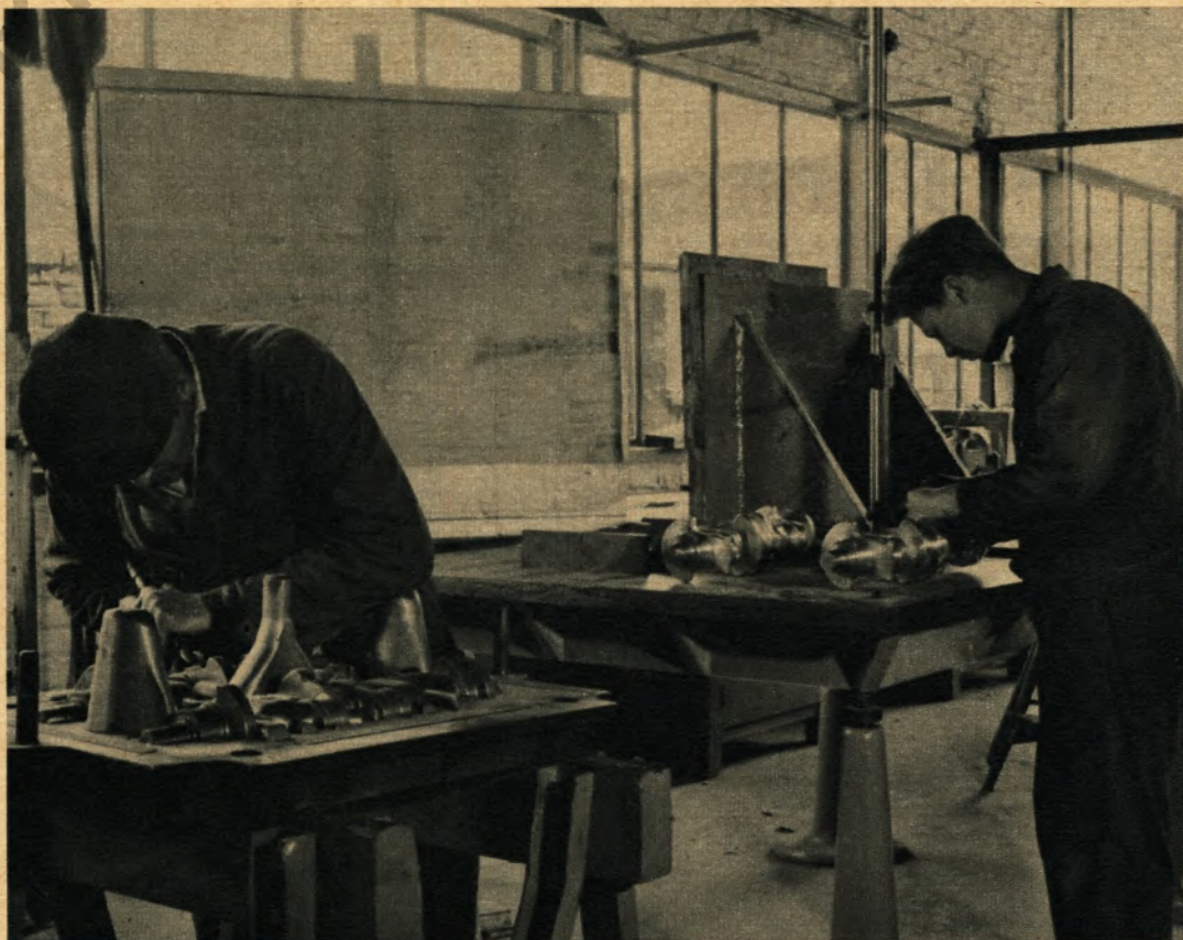
▼ In der Modellmacherei werden künftig nicht nur Holz-, sondern auch Metallmodelle der herzustellenden Werkstücke selbst angefertigt. Arno Waldow (links) und Jürgen Gebhardt bearbeiten gerade Kurbelwellenmodelle
