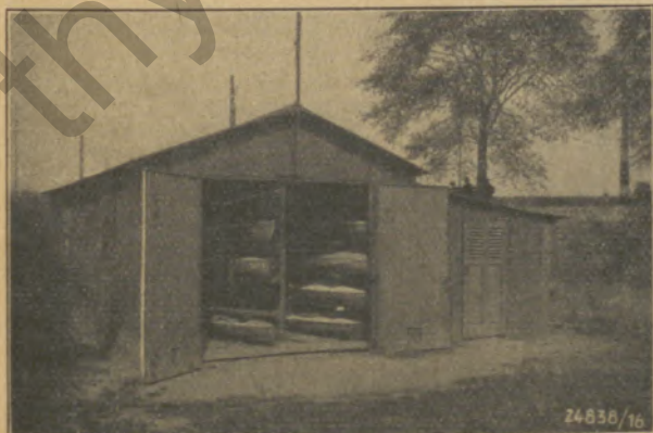
Altes Bootshaus der Hamborner Kanu-Vereinigung 1925—1930
