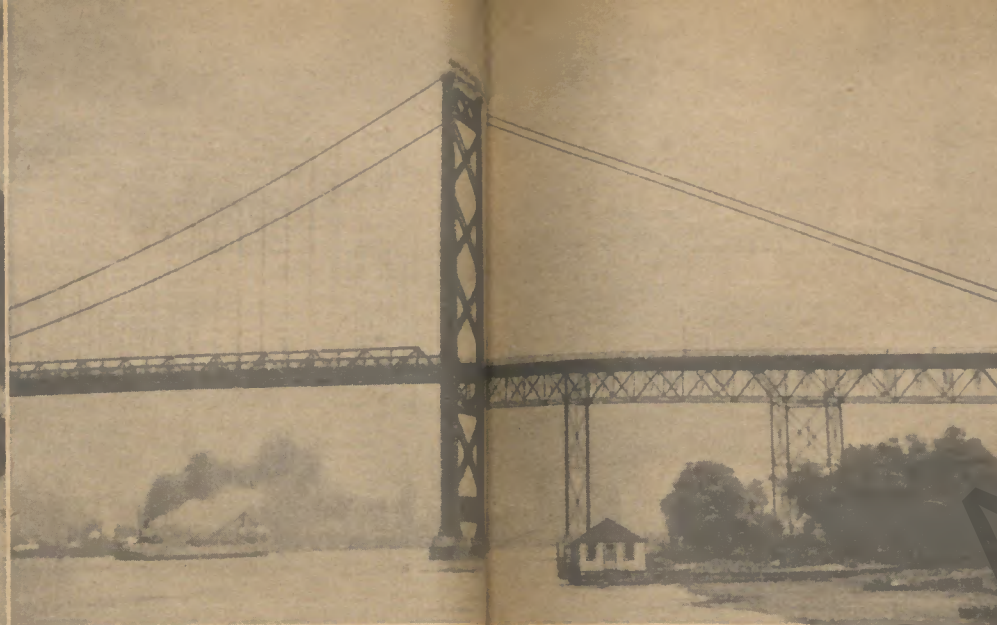
Ambassador-Bridge über den Detroit-Fluß verbindet die USA. mit Kanada (Straßenbrücke). — Im Hintergrund Detroit
