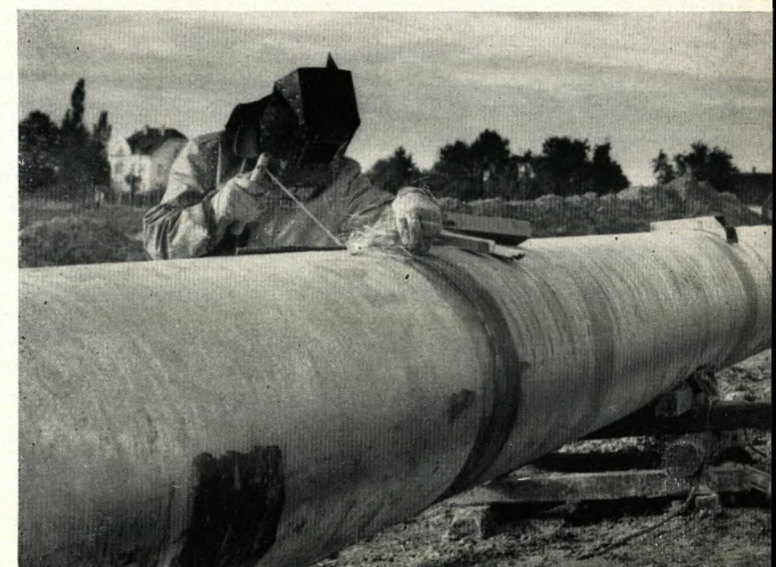
Oben: Die Rundschweißungen entstehen nach dem Abwärts- oder Fallnaht-Schweißverfahren
