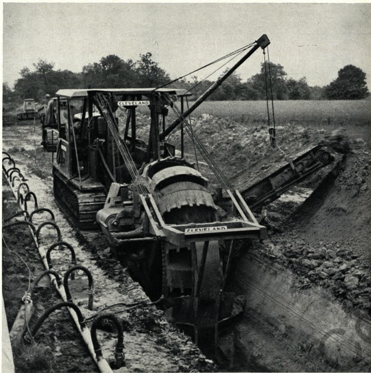
Der Ditcher, die Grabenfräse, hebt mit seinen Schaufeln den Erdboden aus und häuft ihn zu einem Wall auf
