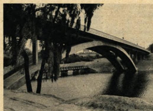
▲ Auch diese Hagener Brücke über den Ischelandteich wurde mit Hilfe eines Lehrgerüsts der Schmiedag erbaut
