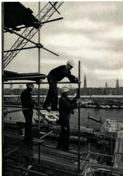
Titelseite: Überall, wo große und interessante Bauvorhaben verwirklicht werden, ist die Schmiedag mit ihren Stahlrohrgerüsten dabei – wie hier im Hamburger Freihafen, wo eine Gerüstbaukolonne der Schmiedag – v.l.n.r.: Jochen Templin, Helmut Minnerop (oben) und Werner Anders – das Stahlrohrgerüst für ein neues Kraftwerk Stockwerk um Stockwerk höherzieht
