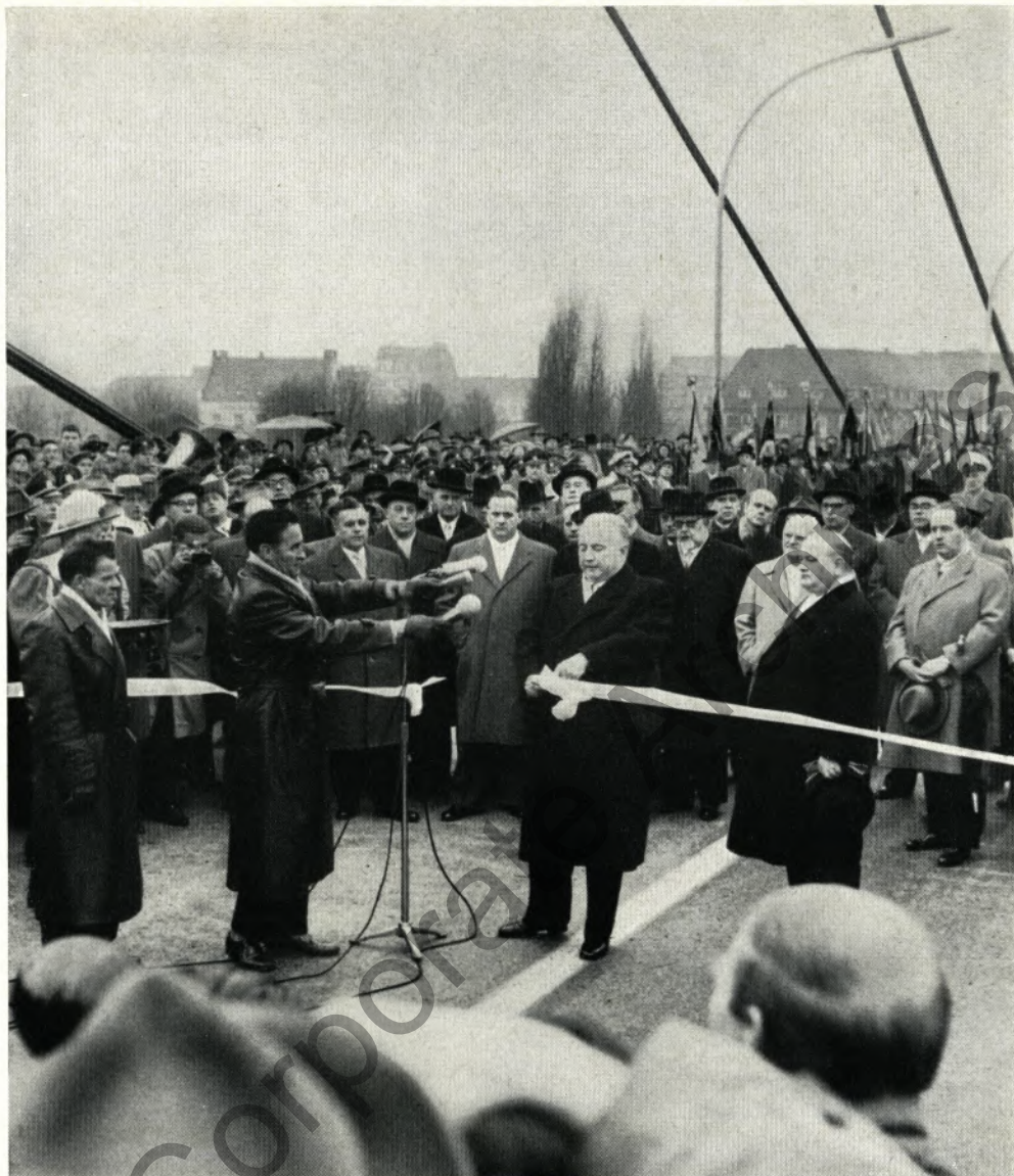
Die Düsseldorfer Nordbrücke wurde am 19. 12. dem Verkehr übergeben. Phoenix-Rheinrohr ist an der Lieferung der dafür verwendeten Bleche mit rund 2000 t beteiligt. Der Hauptanteil entfällt auf unseren Sonderstahl HSB 50. Vertreter dreier Konfessionen segneten die Brücke ein. Bundesverkehrsminister Dr. Seehofer durchschneidet das weiße Band. Links hinter ihm Landesverkehrsminister Dr. Kohlhasse, rechts Bürgermeister Dr. Vomfelde. Die Brücke verbindet das Ruhrgebiet mit dem linken Niederrhein und den Nachbarländern
