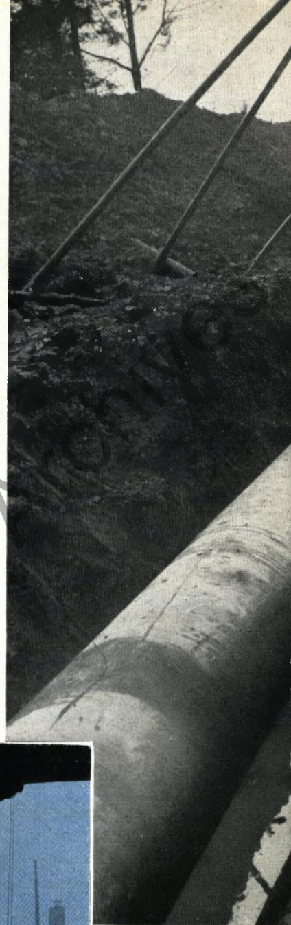
↑ Rohr fügt sich an Rohr zu der rund 15 km langen Trinkwasserleitung
