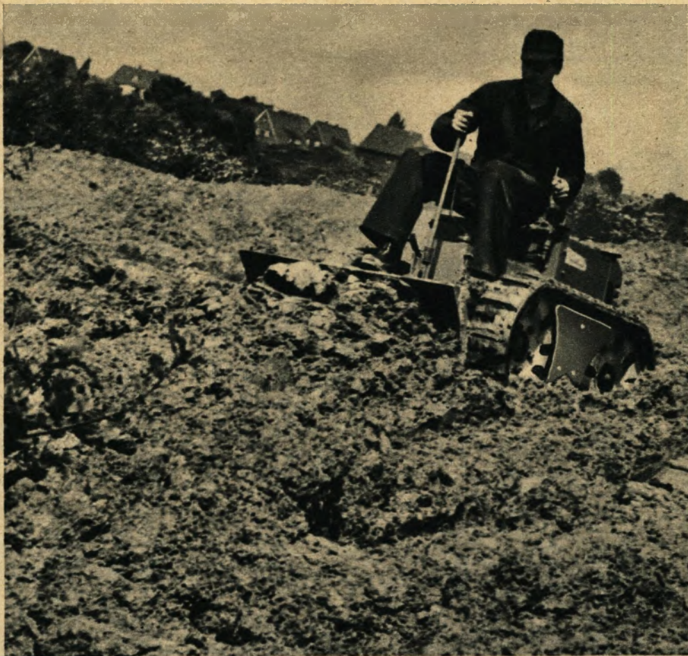
Angeschütteter Mutterboden darf nur von einer Kleinraupe planiert werden – Großraupen würden die Bodengare zerstören
