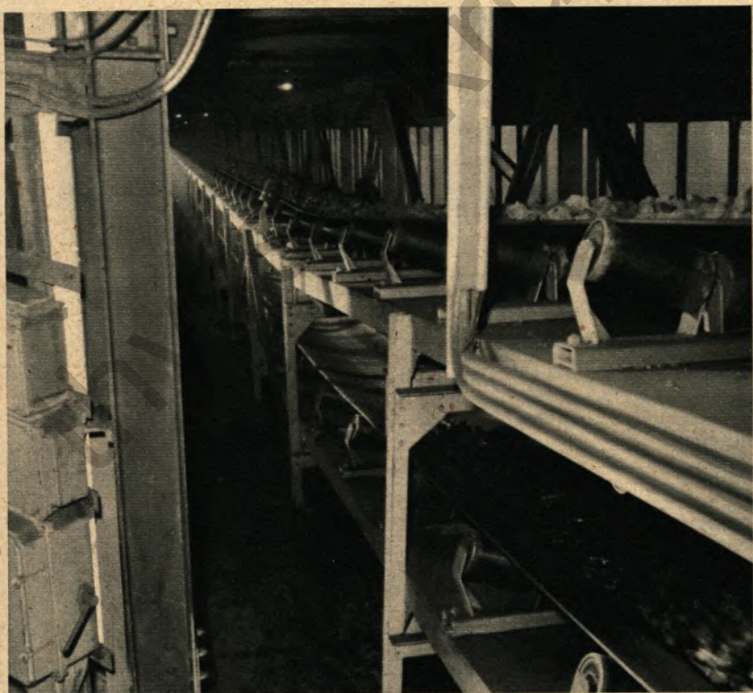
Bild oben Die Landabsatzanlage der Schachtanlage Radbod ist ein neues Wahrzeichen d. Zeche
