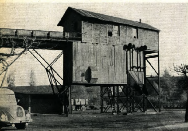
Die alte Kohlenkippe auf Radbod! An ihrer Stelle steht heute eine moderne Landabsatzanlage (Bericht auf Seite 142)
