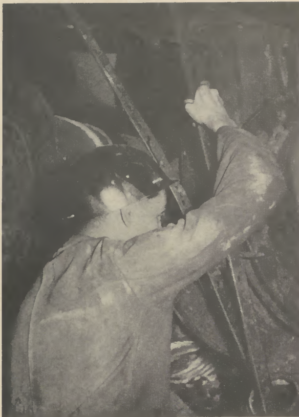
Den Cowper-Wärter schützt der Helm sowohl gegen herabfallende Gegenstände als auch gegen Stichflammen.
