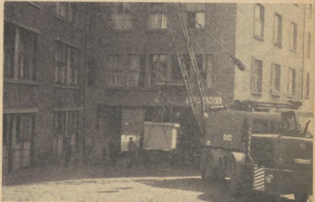
Bild 2: Transport der Anlage mit einem großen Kran durch das Konferenzzimmer in den früheren Raum des Betriebsrates
