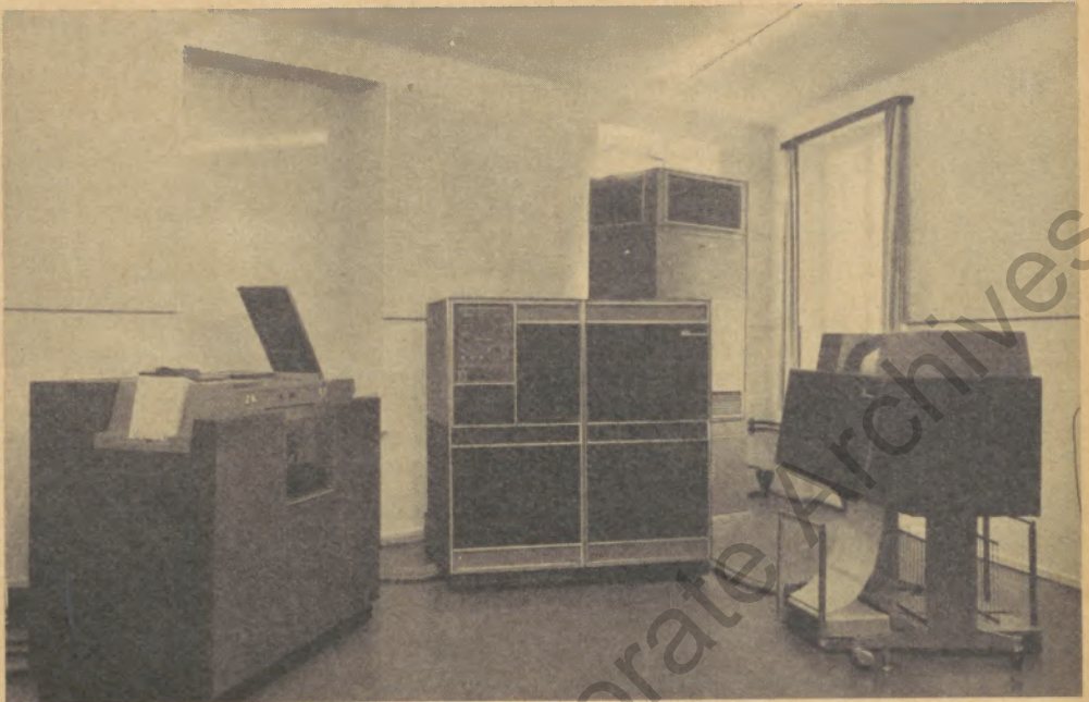
Bild 3: links: Kasteneinheit 1402 · mitte: Zentraleinheit 1401 · rechts: Drucker 1403 · Hintergrund: Klimaschrank
