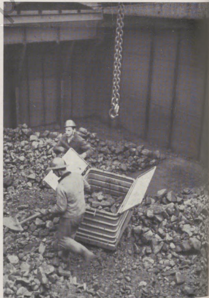
Im Laderaum eines Rheinkahns werden Erzproben in den Probekübel gefüllt; er faßt bis zu zwei Tonnen
