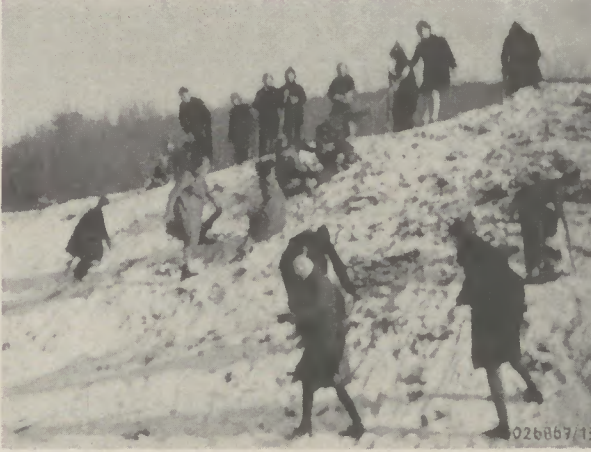
Berge runterrutschen macht Spaß
