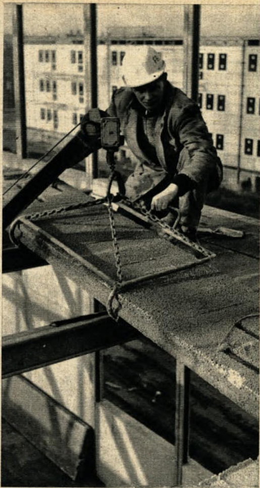
▲ Einer der größten Vorteile der Hoesch-Fertigbauweise ist die leichte Montage der Einzelteile. Wie unser Bild zeigt, genügt ein einfacher Kran, um die Fußbodenplatten auf die Stahlträger zu heben
