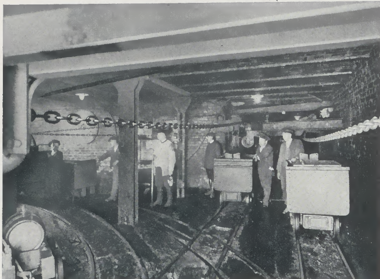
Möncheberg: Hauptkettenbahn mit Abzweigungen
