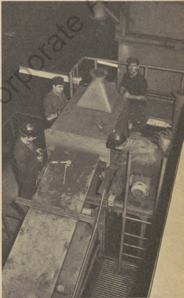
Bild 1: Montagearbeiten an der Übergabe eines Gurtförderers der Formstoffaufbereitung.
