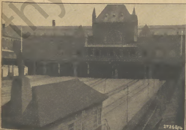
Anlage des unterirdischen Kopenhagener Hauptbahnhofes
