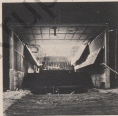
▲ Der fertige Stahl fließt aus dem Konverter in die Gießpfanne
