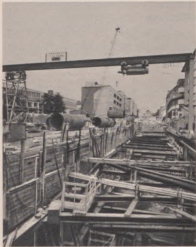
89 Rohrabchnitte von zwei Meter Durchmesser retten einen Häuserblock in Hamburg-Harburg
