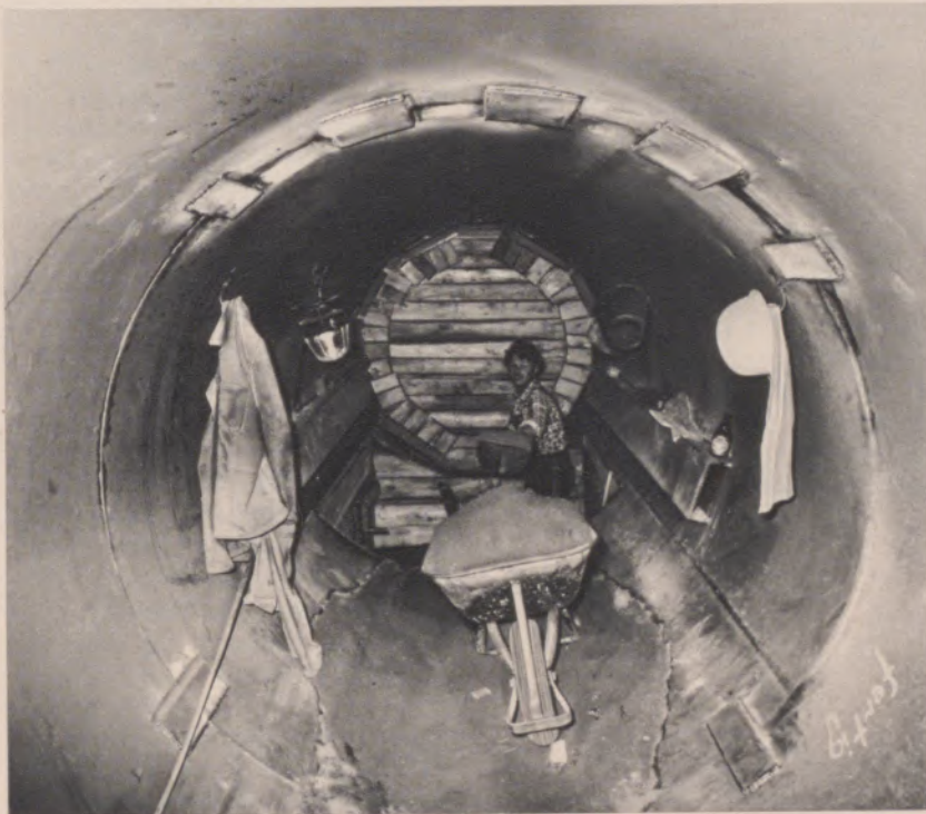
25 nebeneinanderliegende Rohre bilden die den Häuserblock tragende Rohrschirmdecke
