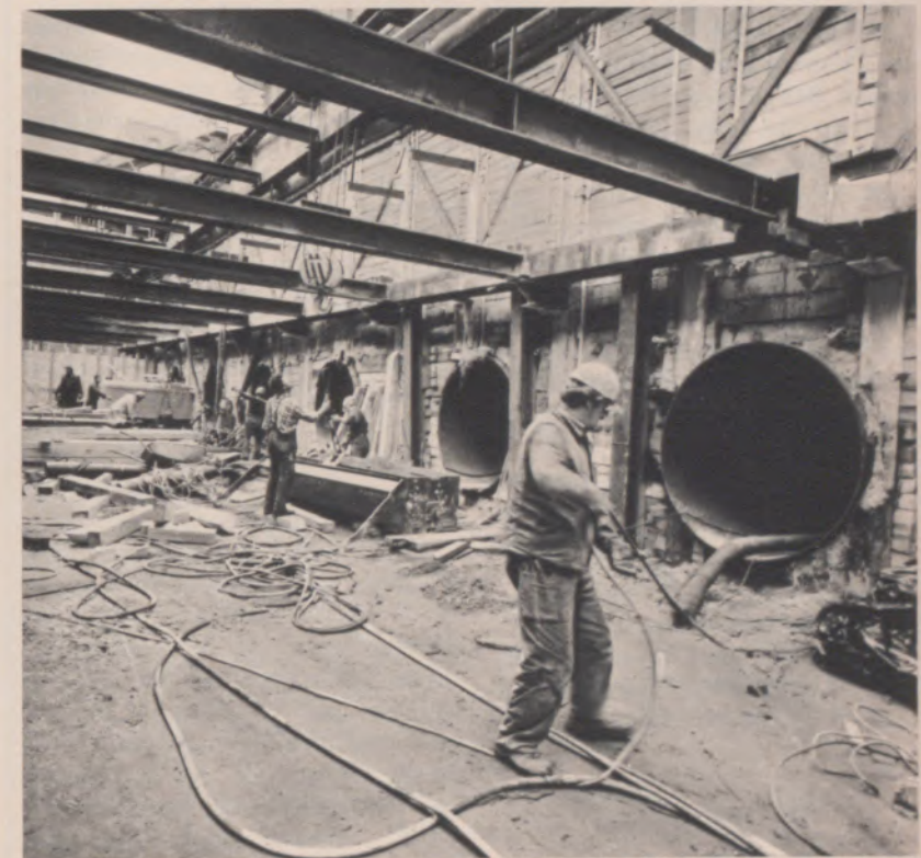
25 nebeneinanderliegende Rohre bilden die den Häuserblock tragende Rohrschirmdecke
