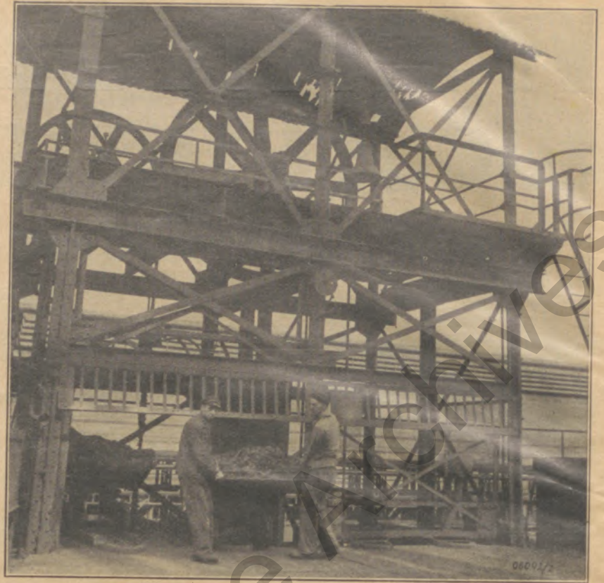
Der Aufzug bringt die gefüllten Wagen zur Gicht
