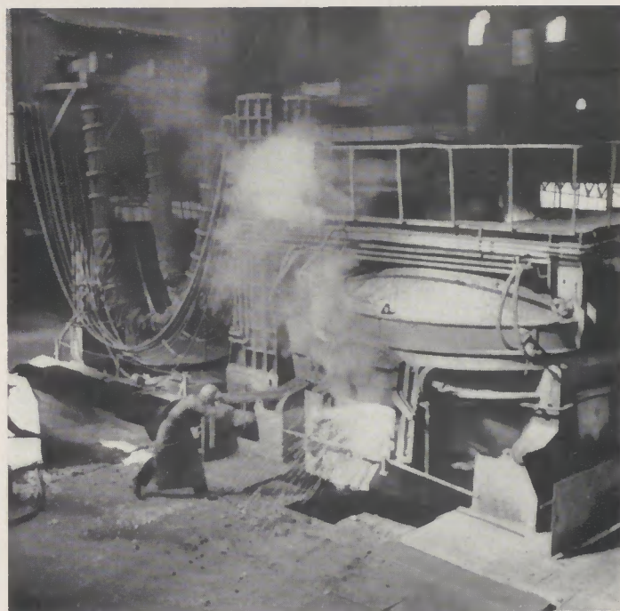
Bis jetzt noch allein: der Bau eines zweiten Elektroofens wird bald in Angriff genommen
