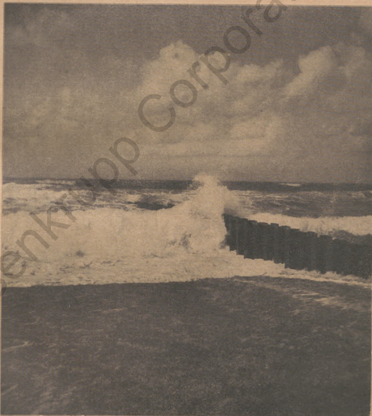
Bühne aus Stahlspundbohlen „Larssen“ am Strand der Insel Sylt
