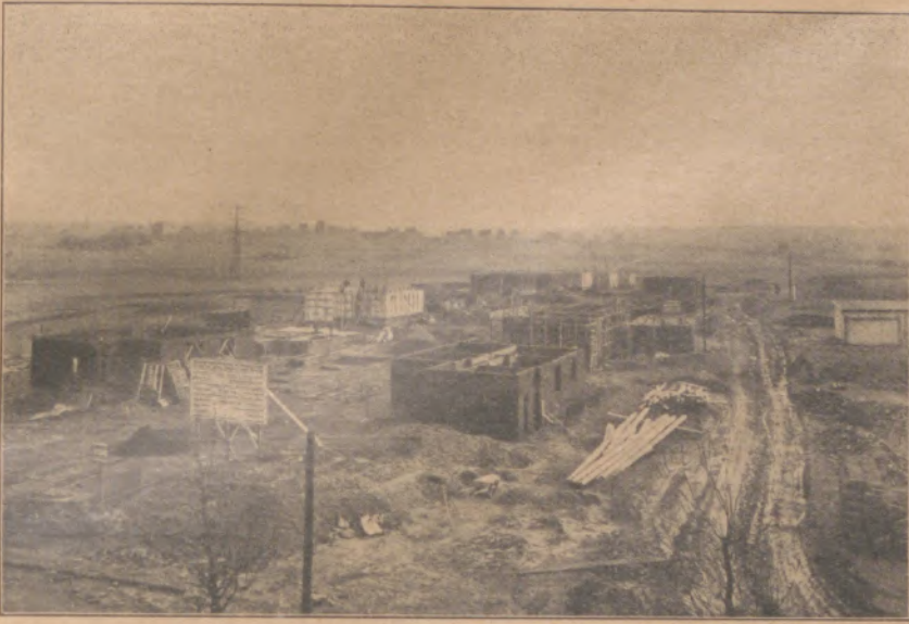
Abb. 2: Eigenheimgruppe an der Verbindungsstraße zwischen Hörder Kampweg und Rattenkuhle
