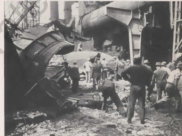
Wasserbehälter stürzte um: Als am 12. Juli gegen 12.10 Uhr der 30 m hohe, halbvolle Wasserbehälter hinter dem Hochofen I mit Gefölse zusammenstürzte und dabei einen Teil des alten Hochofen-Maschinenhauses, die „Portugiesenbude“ und ein WC unter sich begrub, glaubte man im ersten Augenblick an eine Katastrophe. Doch glücklicherweise — es war Sonntag mittag — war kein Mensch zu diesem Zeitpunkt im Einsturzbereich gewesen. Allerdings mußte die Feuerwehr 200 cbm Wasser aus der Möllierung pumpen; mit Schweißbrennern und Seilwinden mußte in Tag- und Nachtschicht das Stahlgewirr entknotet werden, und der Hochofen III lief aus Sicherheitsgründen nur gedämpft. Eine Gas- und zwei Windleitungen waren arg zerbeult und angeschlagen. Warum der Wasserbehälter überhaupt umstürzte, vermag bis heute niemand zu sagen.
