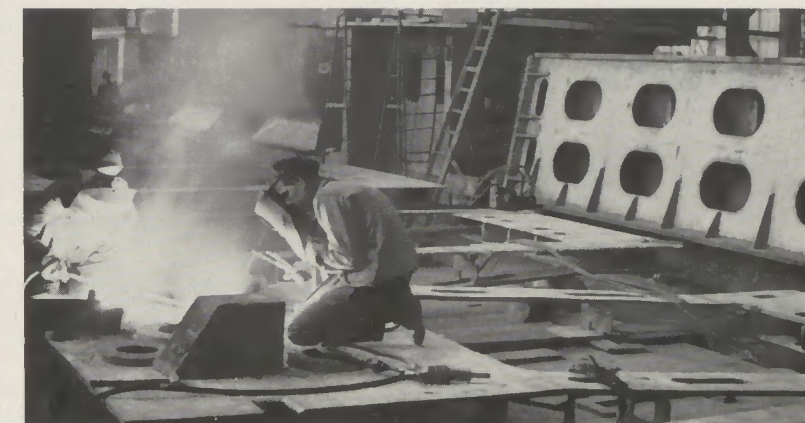
Schwere Brocken: Die automatische Unter-Pulver-Schweißanlage der Henrichshütte bewährt sich gut
