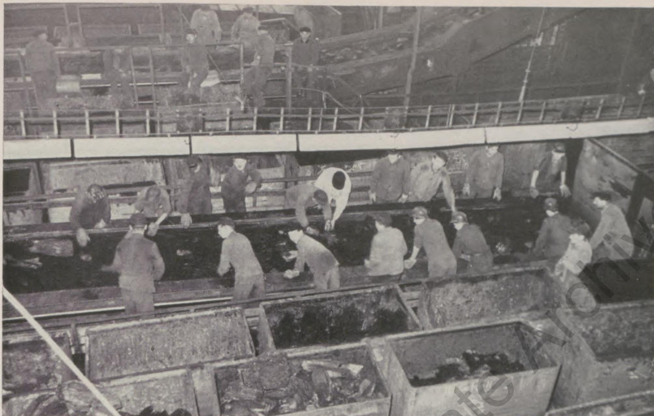
Abb. 4: Leseband. Mitgeführte Berge werden geklaubt
