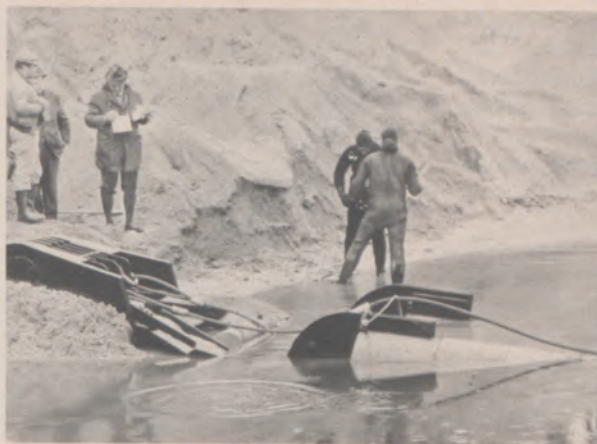
◀ Die Zugtalje am Dükerkopf hebt sich aus dem Wasser. Über Funk wird das gegenüberliegende Ufer informiert, daß alles geklappt hat. Die Taucher sprechen sich ab, wie sie die Schwimmer von den Rohren lösen wollen
