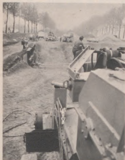
▲ Zügig arbeiten die Winden: Drei Meter in der Minute ziehen sie das Rohrbündel durch den Strom
