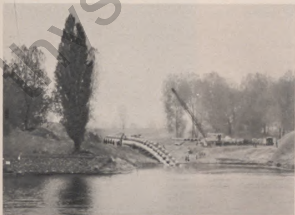
◀ Der Schwanz ist in Sicht: Hier wird deutlich, welche Krümmungen die Rohre aushalten haben
