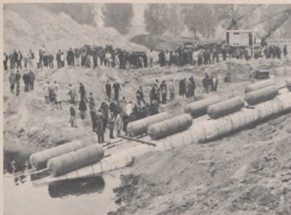
◀ Die auf den Rohren befestigten Behälter – Schwimmer genannt – sorgen für Auftrieb
