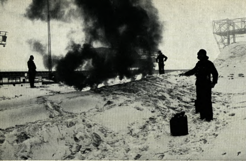
Mit brennendem Koks und Dieselöl werden Erzberge aufgetaut.
