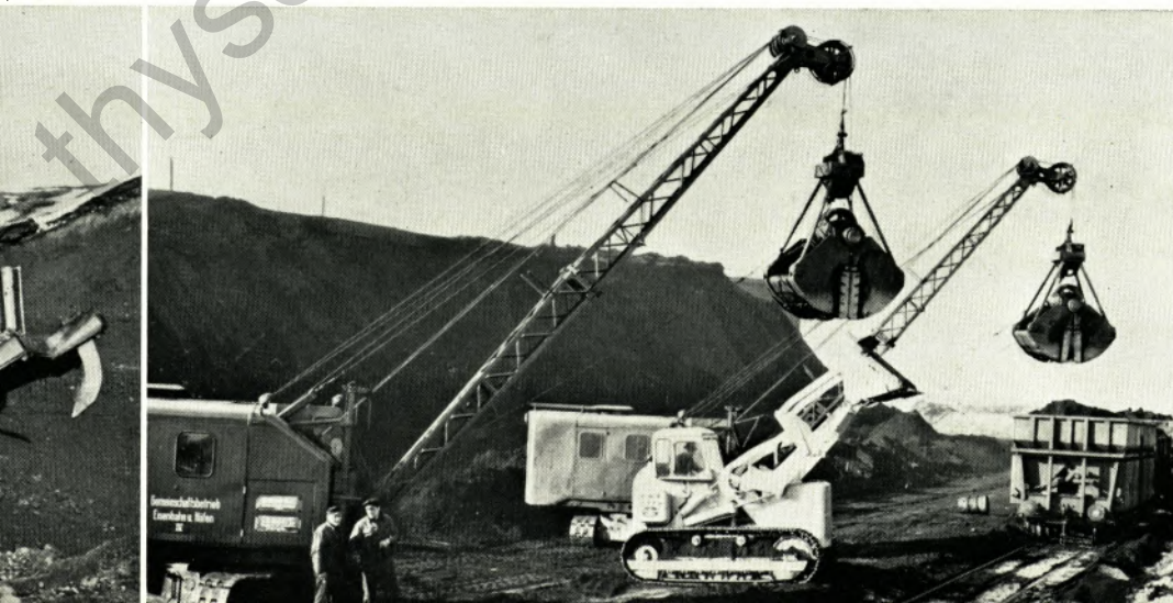
Drei Auflagegeräte sind an der Sydvaranger-Kippe zur Beladung der Erzselbstentlader eingesetzt.
