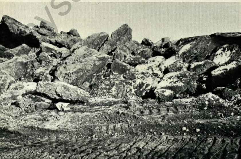
Der „Caterpillar“ hat die Kiiruna-Kippe am Nordufer aufgerissen. Die gefrorenen Erzbrocken sind gut zu erkennen.
