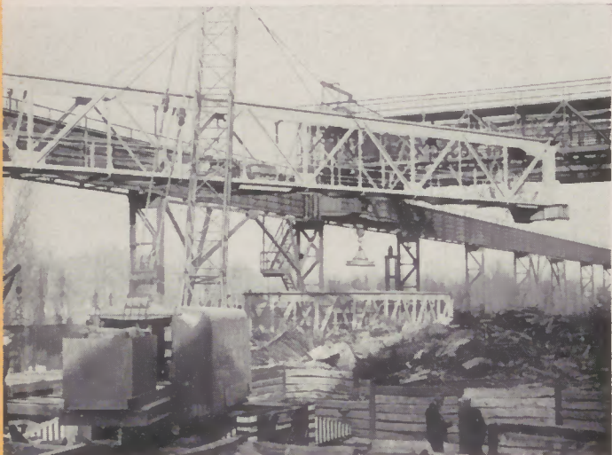
Unser Bild zeigt die Montage eines Schrottmagnetkrans mit einem Gewicht von 52 t und einer Spannweite von 29 m mit Hilfe eines Spezialautokrans. Durch die erstmalige Benutzung eines Autokrans für eine solche Leistung konnte die Montage an einem Sonntag durchgeführt werden (bisher waren 10 bis 12 Tage notwendig).
