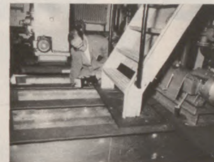
Einige Quadratmeter Bondal an der richtigen Stelle dämpfen den Lärm um die Hälfte
