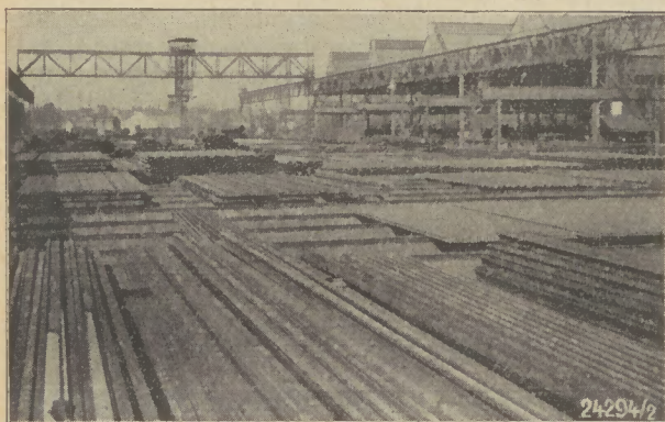
Spundwandisen- und Schienenlager der Dortmunder Union
