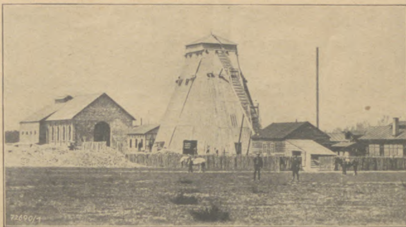
Schacht I der Gewerkschaft Deutscher Kaiser / Abgeteuft um 1870
