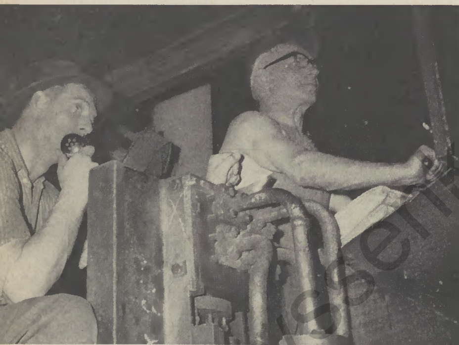
Die Steuerung der 1500-t-Pressen erfolgt noch mittels der bekannten Hebelbewegung. Der 1. Schmelzer gibt die Arbeitsanweisung an seine Kolonne über ein Mikrophon.
