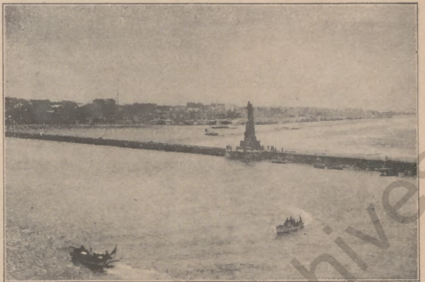
Port Said, Gesamtansicht.
