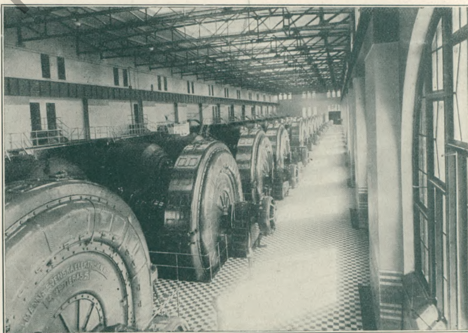
Turbinenraum des Trollhätta-Großkraftwerkes.
