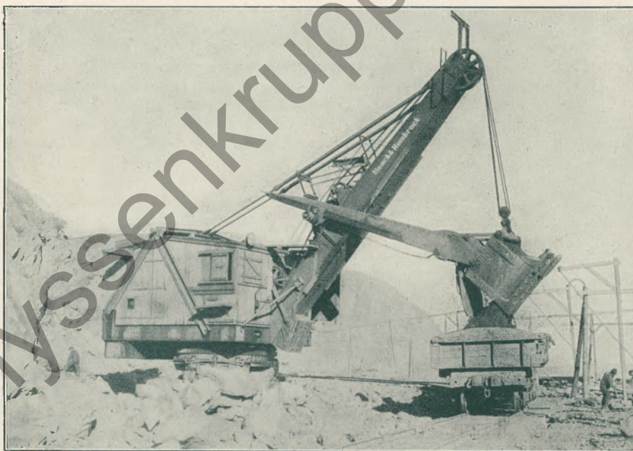
Deutscher Schaufelbagger von 3 cbm Fassung im Eisenerzbergwerk Kirunavara.
