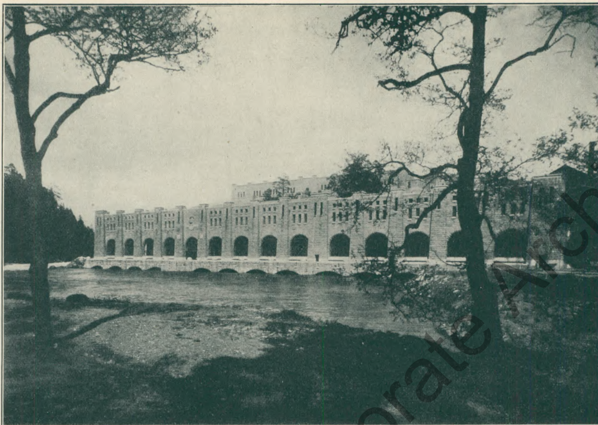
Wasserschloß des Trollhättan-Kraftwerkes.
