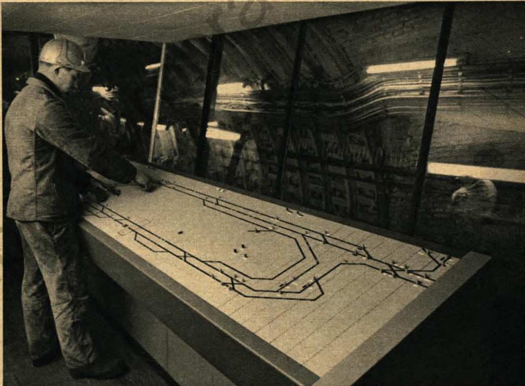
▲ Die letzte Stufe in der Entwicklung zentraler Steueranlagen sind die Gleisbildstellwerke. Eines ist auf Fritz-Heinrich bereits seit zwei Jahren in Betrieb (oben), ein zweites wird jetzt auf Emil-Emscher eingerichtet. Zu ihm gehört auch diese Stellwerkskanzel am Schacht, von der aus die Förderkörbe automatisch „beschießt“ werden. Theo Mosters überprüft die Anlage
