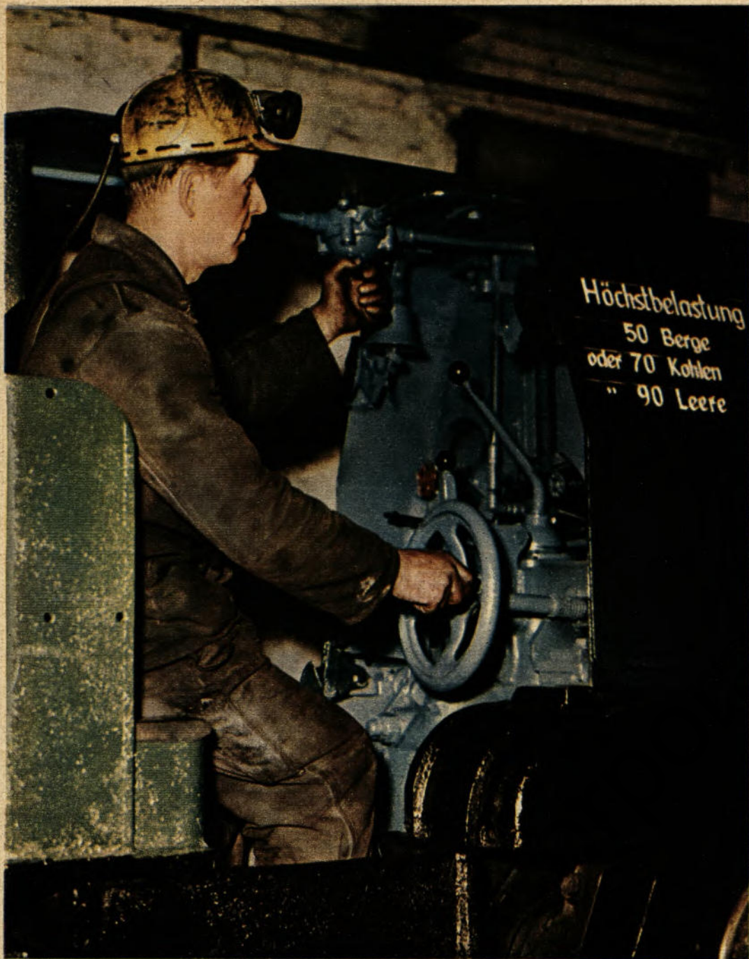
▲ Allein auf Kaiserstuhl sind von den sechzehn Dieselloks, die im Hoesch-Bergbau laufen, dreizehn eingesetzt. Gerd Bergschulte fährt diese Diesellok, die siebzig mit Kohlen beladene Förderwagen schleppen kann
