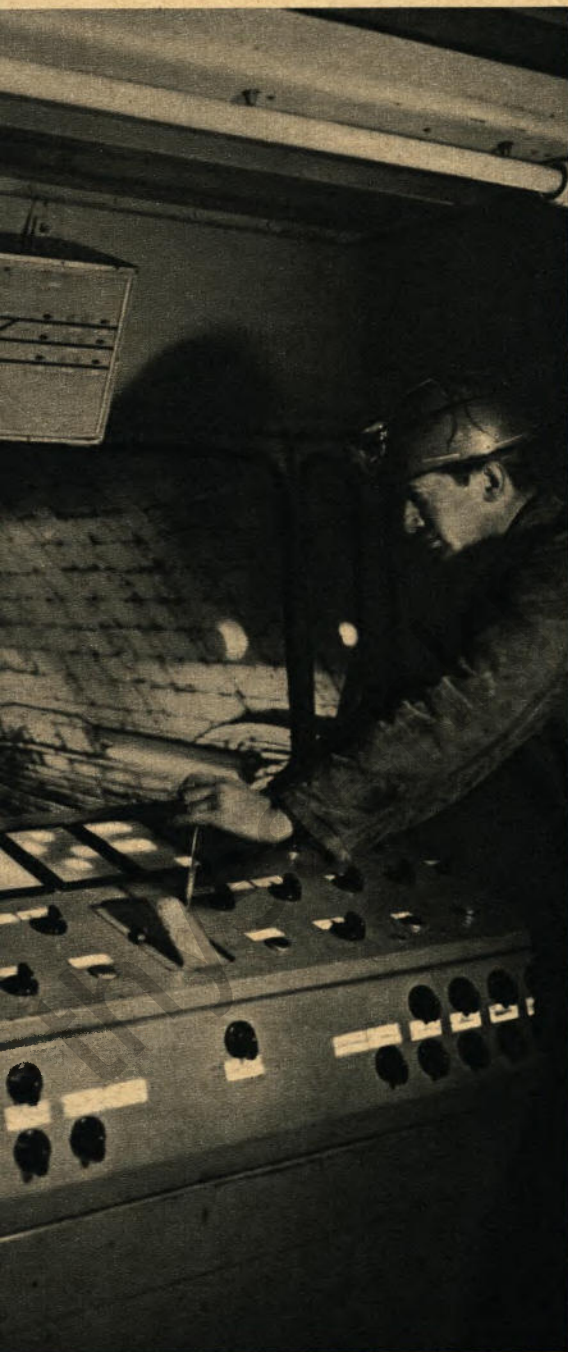
▲ Die letzte Stufe in der Entwicklung zentraler Steueranlagen sind die Gleisbildstellwerke. Eines ist auf Fritz-Heinrich bereits seit zwei Jahren in Betrieb (oben), ein zweites wird jetzt auf Emil-Emscher eingerichtet. Zu ihm gehört auch diese Stellwerkskanzel am Schacht, von der aus die Förderkörbe automatisch „beschießt“ werden. Theo Mosters überprüft die Anlage
