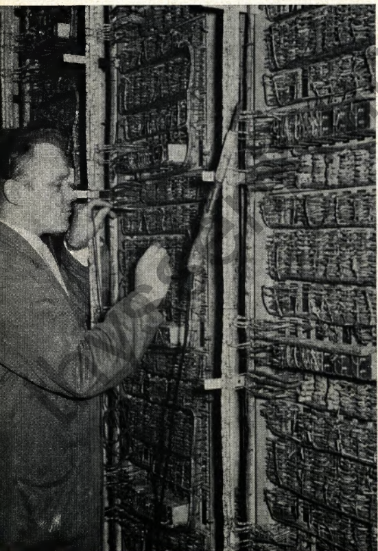
Amtsmechaniker Liesendahl (links) grenzt eine Störung an einer Durchwahlleitung im Werk Poensgen ein. Techniker Görtz und Fernmelde-Mechaniker Stein aus dem Werk Thyssen spüren eine Störung nach den Stromplänen auf, die für jede Telefonanlage vorhanden sind
