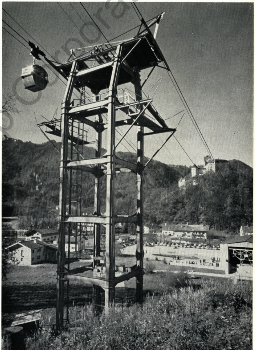
Seilbahnstütze 1 — Hinter der Talstation der Schloßberg mit dem Schloß Hohenaschau
