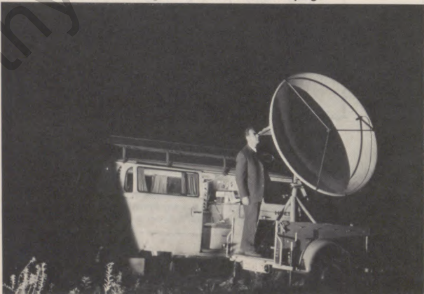
In unserer Versuchsabteilung entwickelter Schallhohlspiegel
