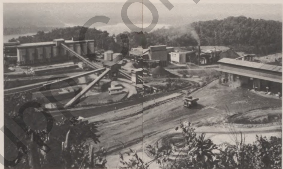
▲ Die Erze der Bong Mining Company werden im Tagebau gefördert und in der Aufbereitungsanlage (im Vordergrund) auf einen Eisengehalt von 65 Prozent konzentriert
