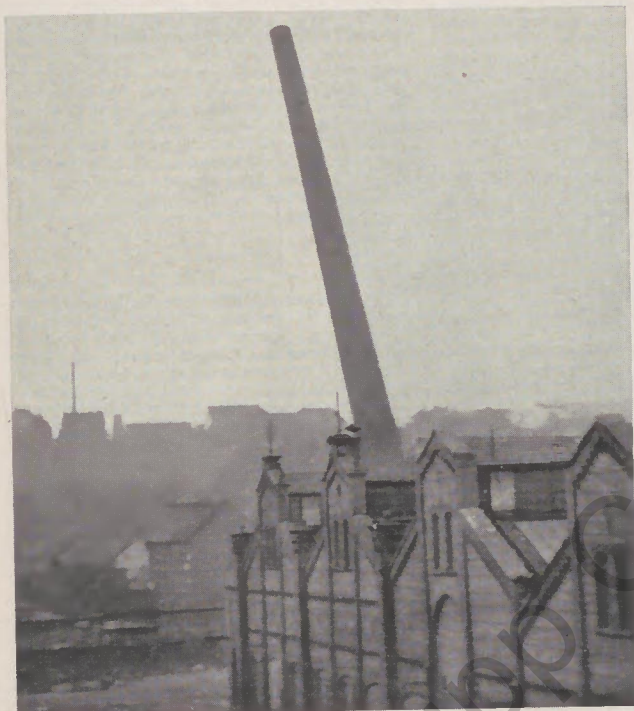
Zum zweitenmal innerhalb weniger Monate wurde ein Schornstein im Werk Rothenditmold „umgelegt“. Der 83-Meter-Riese mit einem Umfang von 6,30 Metern mußte damit wie sein kleinerer Bruder dem Platzbedarf weichen. Unser Bild zeigt den Augenblick kurz nach der Sprengung: der Schornstein beginnt zu fallen.
