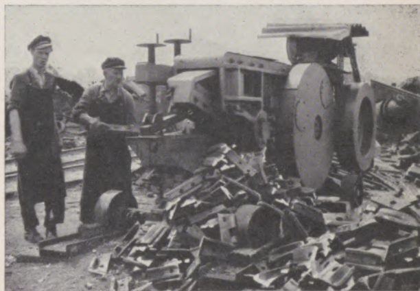
Die neue Schrottschere
