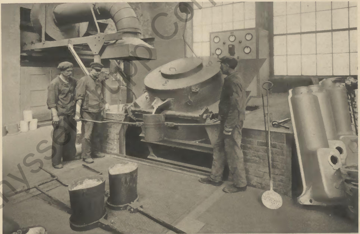
Bild 3: Elektrischer Schmelzofen Bauart Ru für Leichtmetallschmelzungen
