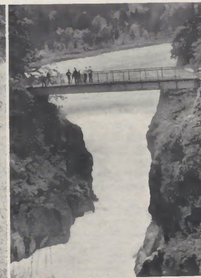
Die Brücke über den Lechfall
