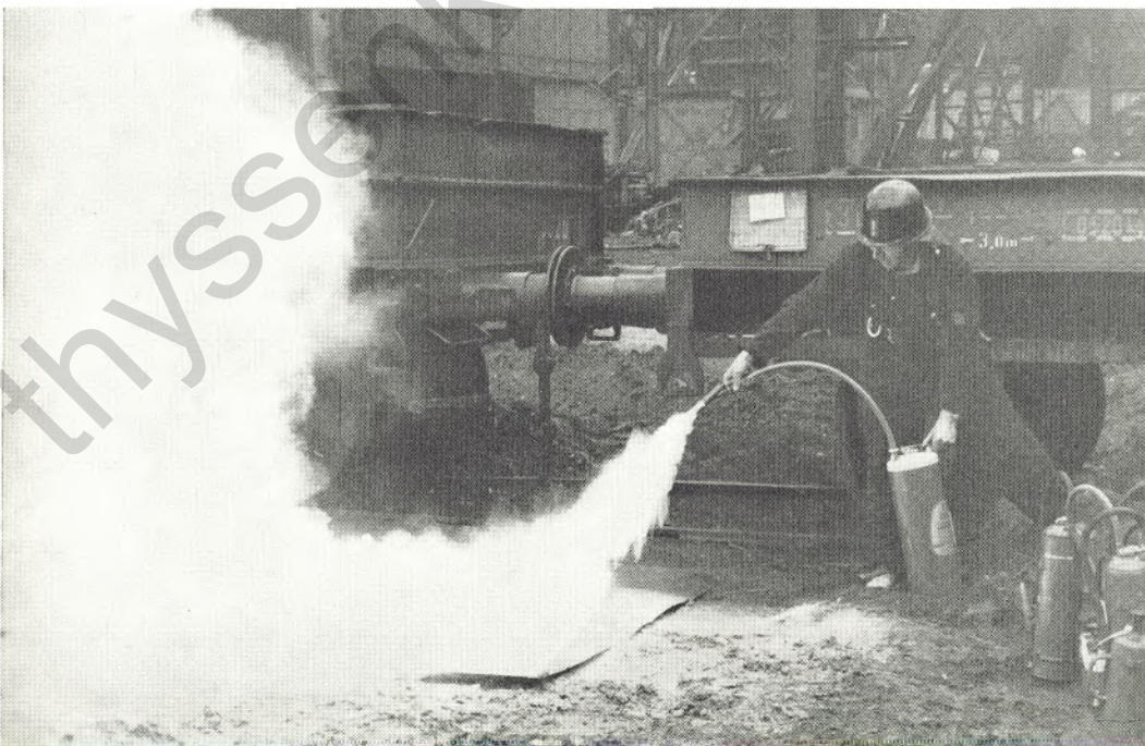
MITTE: Modernes Beatmungsgerät in Tätigkeit — UNTEN: Ablöschen eines Metallbrandes durch ein Spezialpulver-Löschgerät
