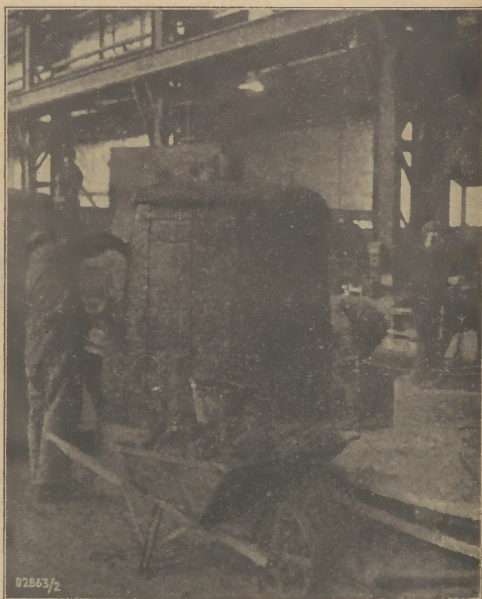
Aufmauern eines Kernes
