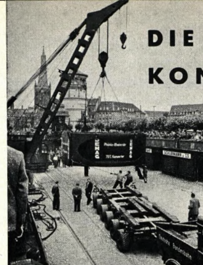
In Einzelteilen wurde der Konverter vom Werk der DEMAG in Benrath auf Spezialfahrzeugen zum Düsseldorfer Hafen gefahren und hier mit großen Kranen auf das Frachtschiff „St. Antonius“ verladen
