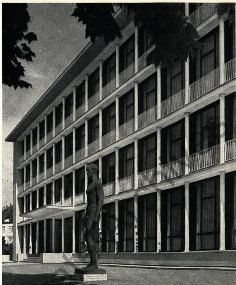
Mit seiner Fassade aus schlanken Stahlrohren präsentiert sich das an einer Hauptausfallstraße zum Ruhrgebiet gelegene „Drahthaus“ in einer modernen Form
