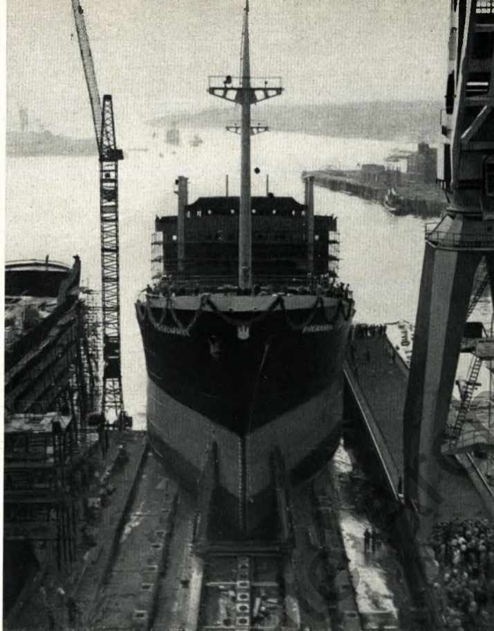
Am 27. August lief der Massengutfrachter „MS Rhenania“, ein Schwesterschiff der „Amelie Thyssen“ und der „Montania“, auf der Werft von Blohm & Voss vom Stapel. Die „Rhenania“ hat wie die beiden zuvorggebauten Schiffe eine Ladefähigkeit von 15 540 Tonnen und eine Antriebskraft von 6 650 PS
