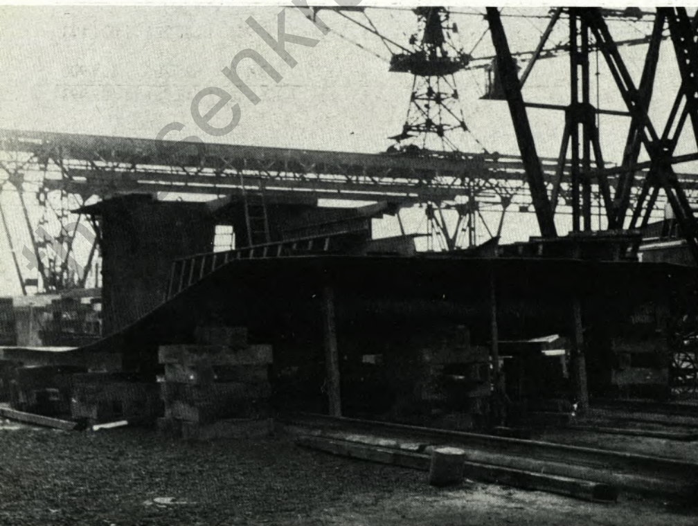
Die Kiellegung der Bodensektion mit Maschinenfundament und hinterem Maschinenraumschott
