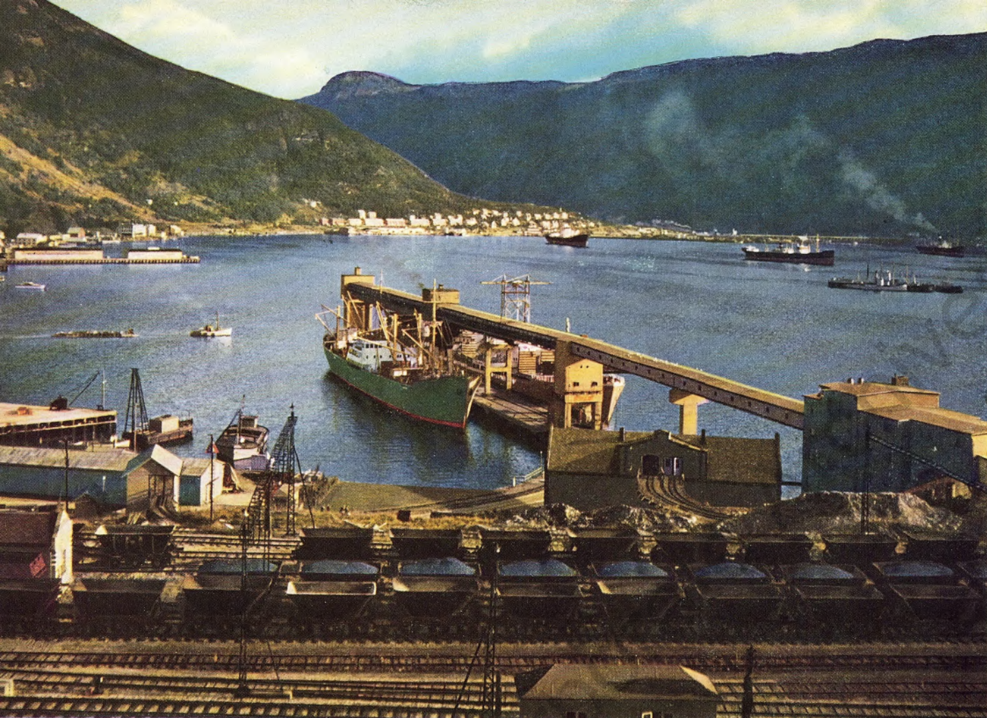
ERZHAFEN NARVIK AM ATLANTIK Endpunkt der Erzbahn von Kiruna. Blick auf den Hafen mit dem Pier, an dem zwei Frachtschiffe gleichzeitig mit Schweden-Erzen beladen werden können
