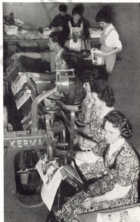
Die fertigen Bogen — bei einem Heft von 24 Seiten, ein Bogen mit sechzehn Seiten und einer mit acht Seiten — werden in der Buchbinderei gefalzt (rechts oben) und danach (mitte rechts) geheftet. Dann gehen sie zum Beschnitt unter eine große Schneidemaschine (unten) und von hier aus durch zahlreiche Hände zum Versand; die Boten warten schon auf die Hefte
